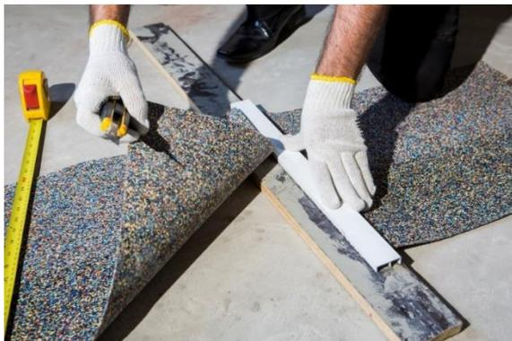
Imagem 6: Foto ilustrativa do corte da Manta Acústica Sound Soft Tubulação com estilete
