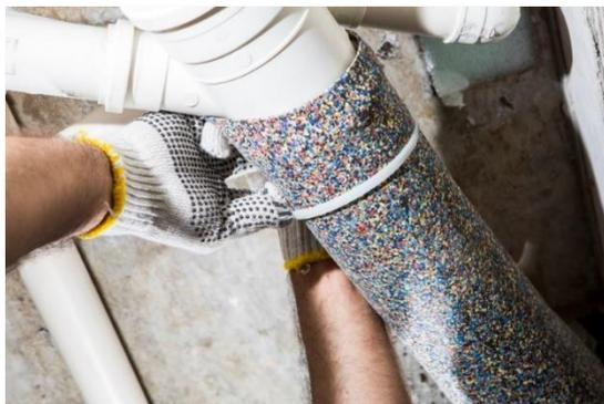
Imagem 7: Foto ilustrativa do envelopamento e aplicação da fita hellerman
