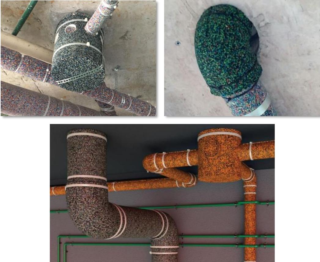
Imagem 9, 10 e 11: Foto ilustrativa do sistema de Mantas Acústicas Sound Soft Tubulação com curva e abafador instalado
