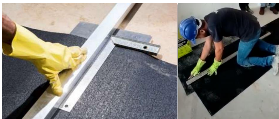
Imagens 3 e 4 Foto ilustrativa do corte da manta Aubicon com estilete
