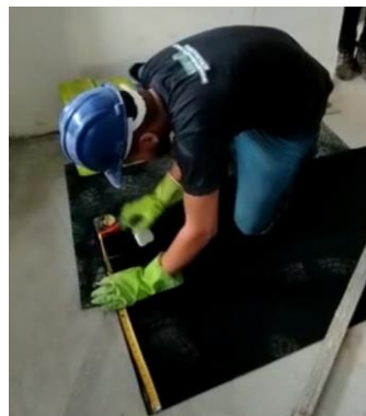
Imagem 2 Foto ilustrativa da marcação da medida do ambiente na manta Aubicon com o giz de cera
