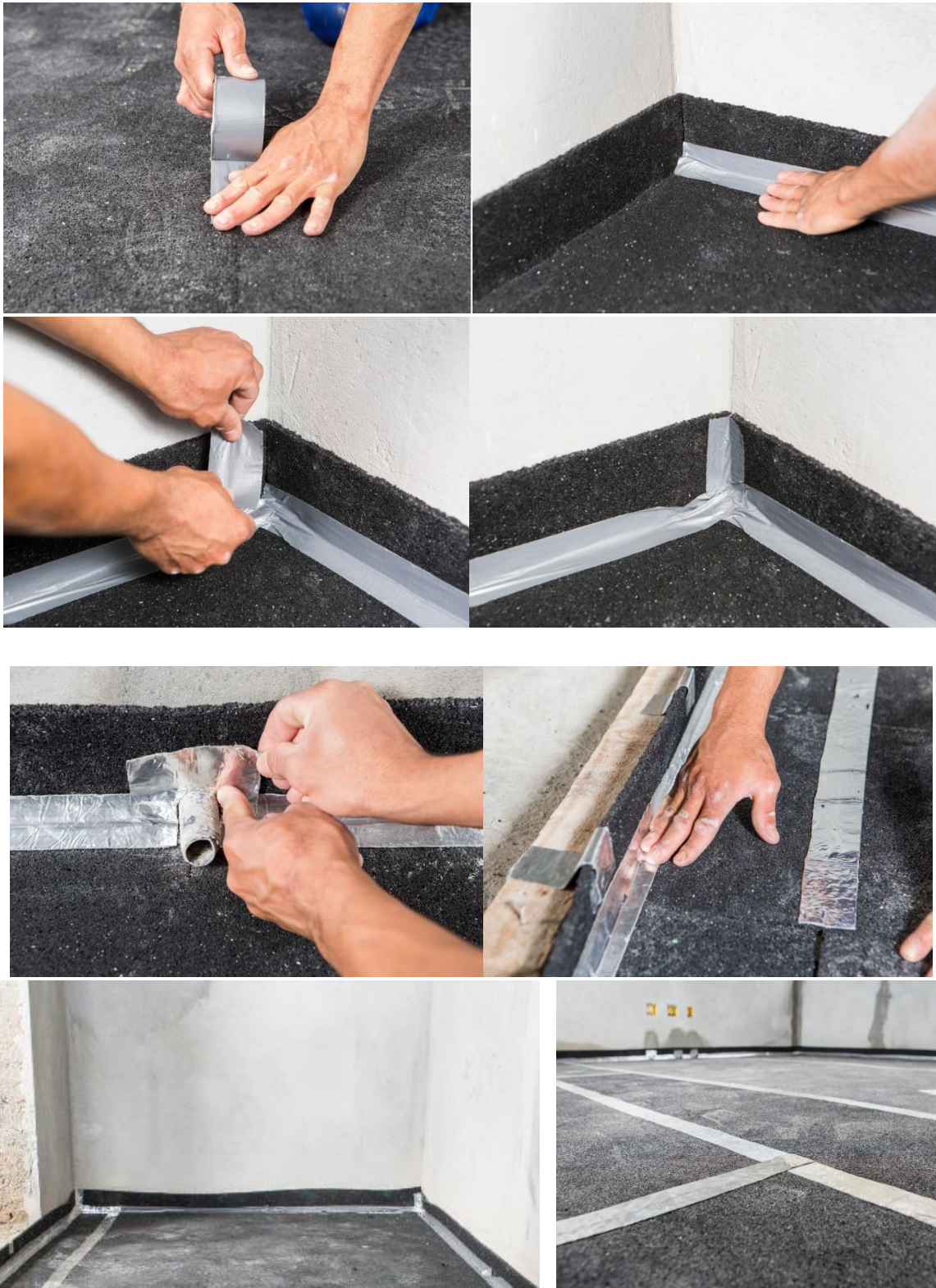
Imagens 23, 24, 25, 26, 27 e 28 Fotos ilustrativas do passo a passo da instalação da "Fita tipo Silver Tape" na Manta e Rodapé
