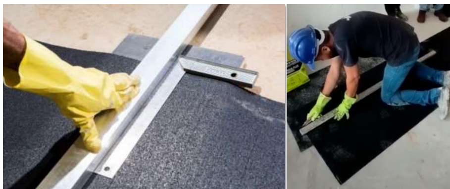
Imagens 6 e 7 Fotos ilustrativas do corte da manta Aubicon com estilete
