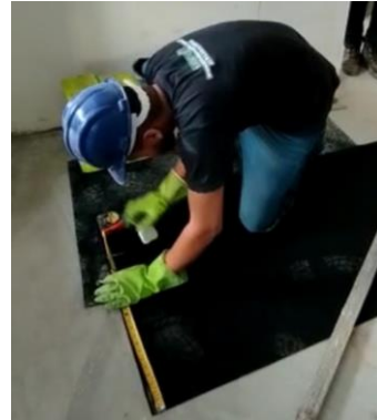
Imagem 5 Foto ilustrativa da marcação da medida do ambiente na Manta Sound Soft com o giz de cera
